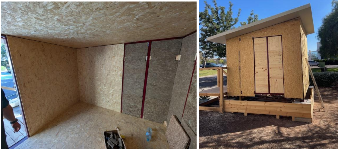
Parte interior y exterior del demostrador con paneles de CLT
